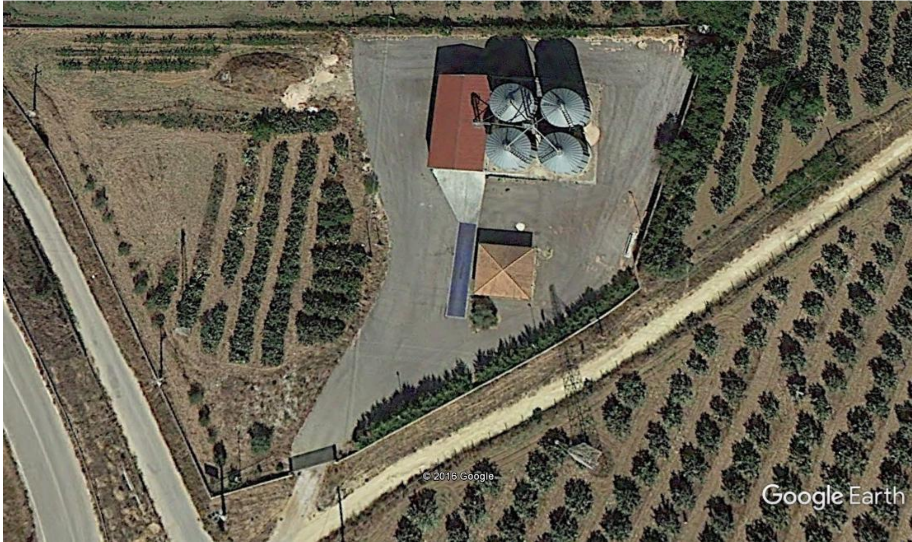
VISTA AEREA PROVE "SILOS"
